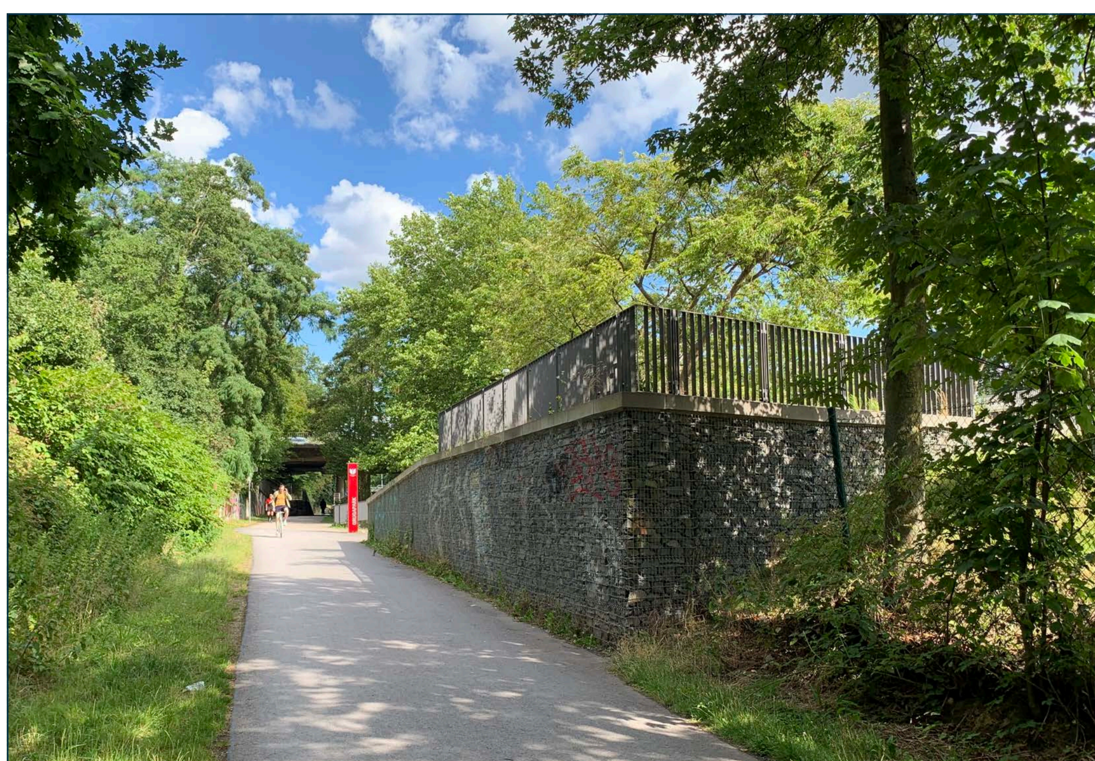
nördlich angrenzende Gruga-Radtrasse mit höherliegendem Gelenkplatz
