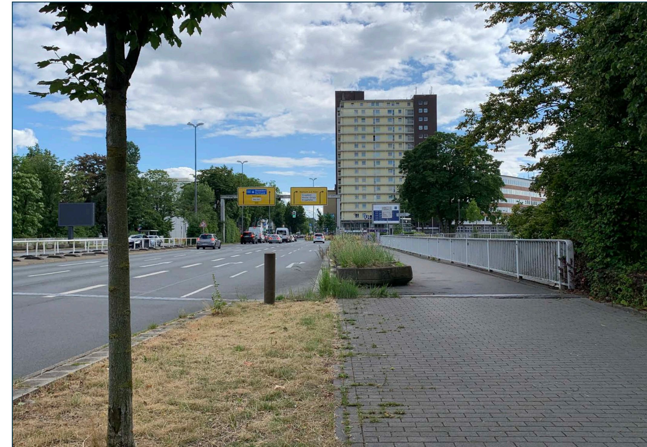
höherliegende Alfredstraße / -brücke
