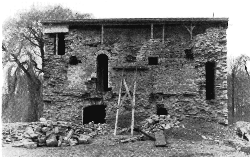
Rest des „romanischen Hauses“ am Stenshof, Südseite. Rechts: Treppenschacht in der Ost-Außenmauer. Links oben: Gang (Treppe?) in der West-Außenmauer
