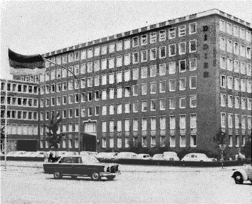
Verwaltungsgebäude der Didier-Werke
